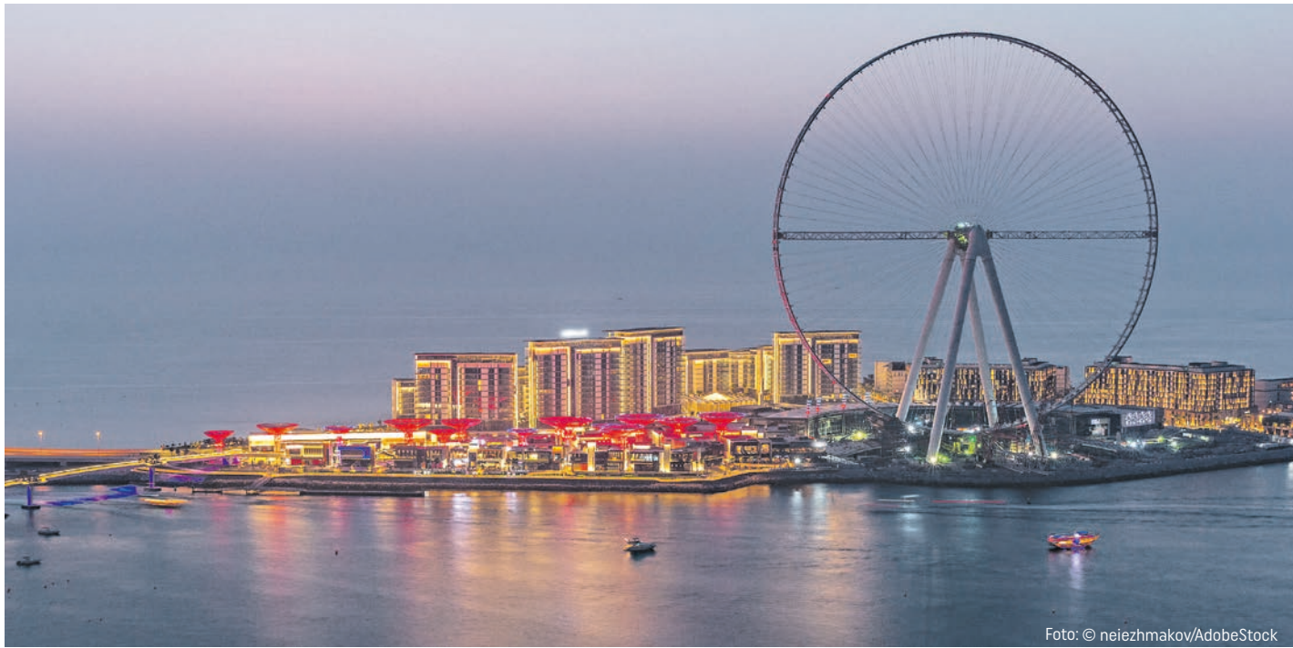
Was hat ein Netzschutzanalyse-Tool aus dem Saarland mit »Ain Dubai«, dem höchsten Riesenrad der Welt, zu tun? Berechnungen von GridProtect lieferten die Basis, auf der alle elektrischen Betriebsmittel plus Schutztechnik des 240 Mio. Euro teuren »Expo 2020«-Projekts am Persischen Golf dimensioniert wurden.
