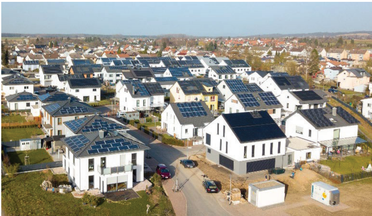
Abbildung II-72: Netzlabor mit Quartierspeicher im Baugebiet „Am Umstädter Bruch“ (Eigene Darstellung)
